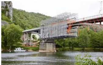
Aménagement de voiries avec composante TEE, ouvrages d'art
